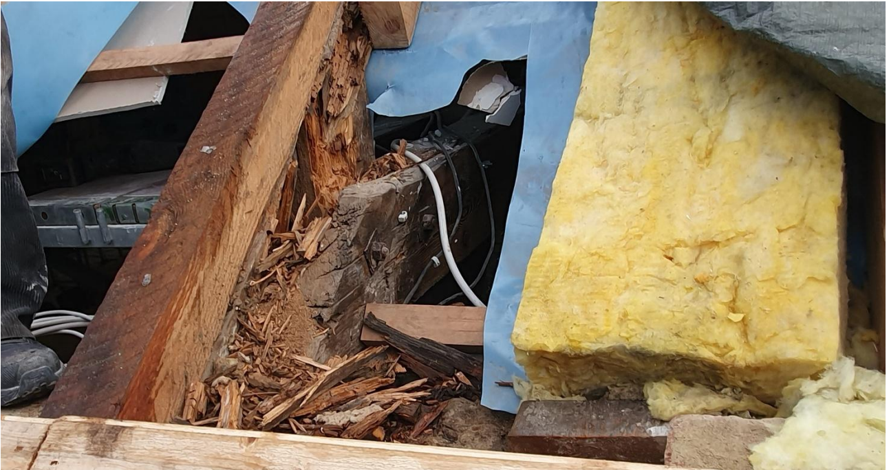
Nur noch Holzstaub, wo eine feste Verbindung sein sollte.
