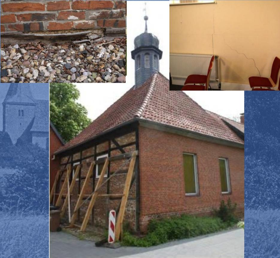
Im Bereich der Kapelle der Stiftsanlage besteht ein Sanierungsbedarf aufgrund absackender bzw. beschädigter Außenwände und notwendiger Ertüchtigungen im Bereich des Dachstuhls.
